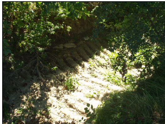
Curage du Langis en aval de la D151
