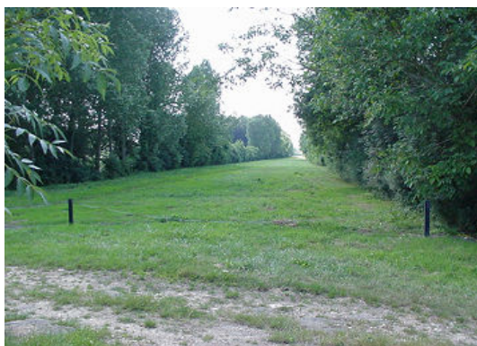
Photographie d'une portion du canal remblayée
