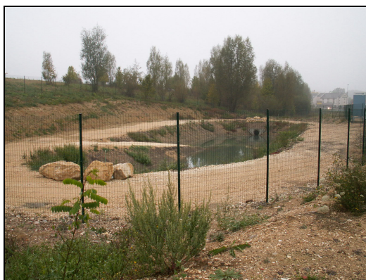
Bassin de traitement des eaux pluviales de l'A. 71 à Vierzon
